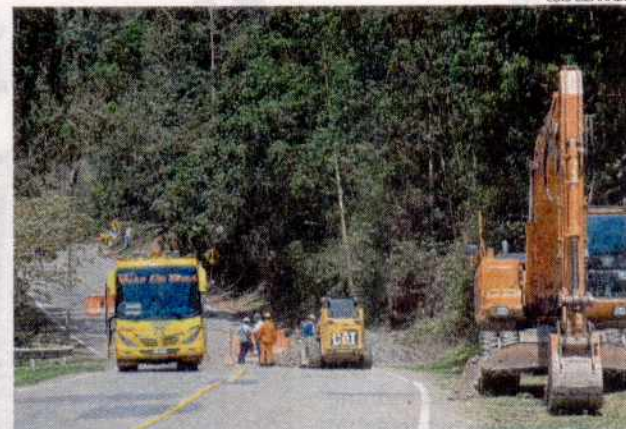
Asegura el concesionario que en cuanto a la rehabilitación vial, Martínez explicó que esta incluía la pavimentación de toda la vía.
